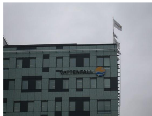
Lovpliktiga åtgärder – fasadskylt och flaggborg
